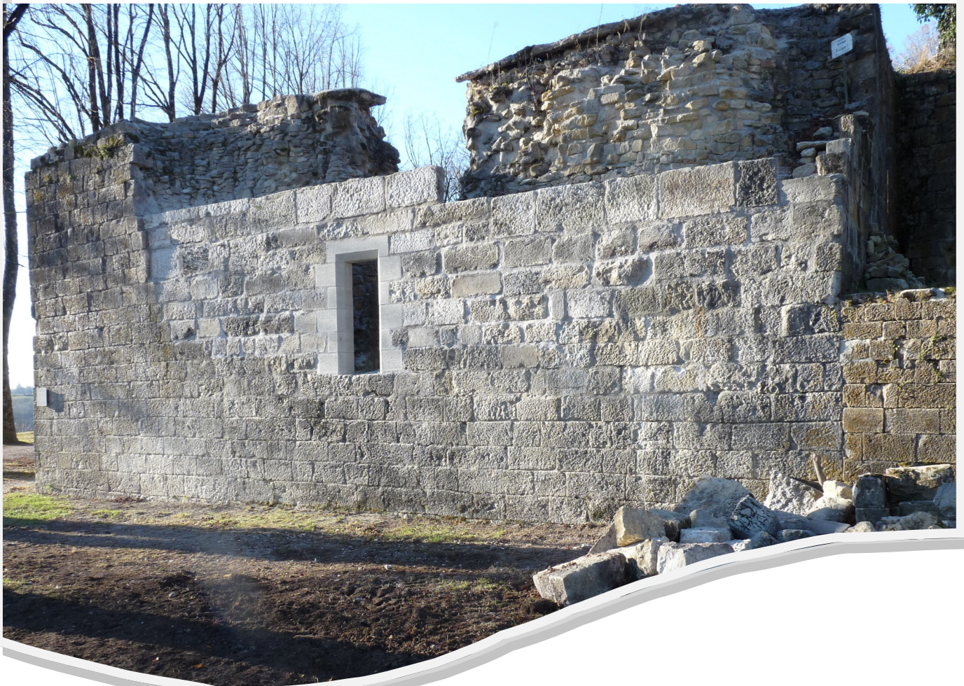
Mur 16 extérieur en Décembre 2016
